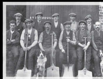
Personnel de la distillerie, 1890
